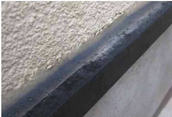
Spoji izvedeni s tesnilnimi trajno elastičnimi kiti
