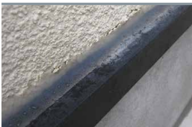
Spoji izvedeni s tesnilnimi trajno elastičnimi kiti
