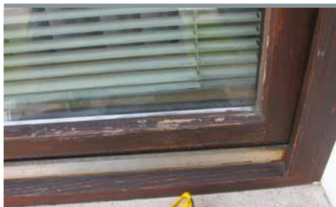
Opuščena redna obnova
